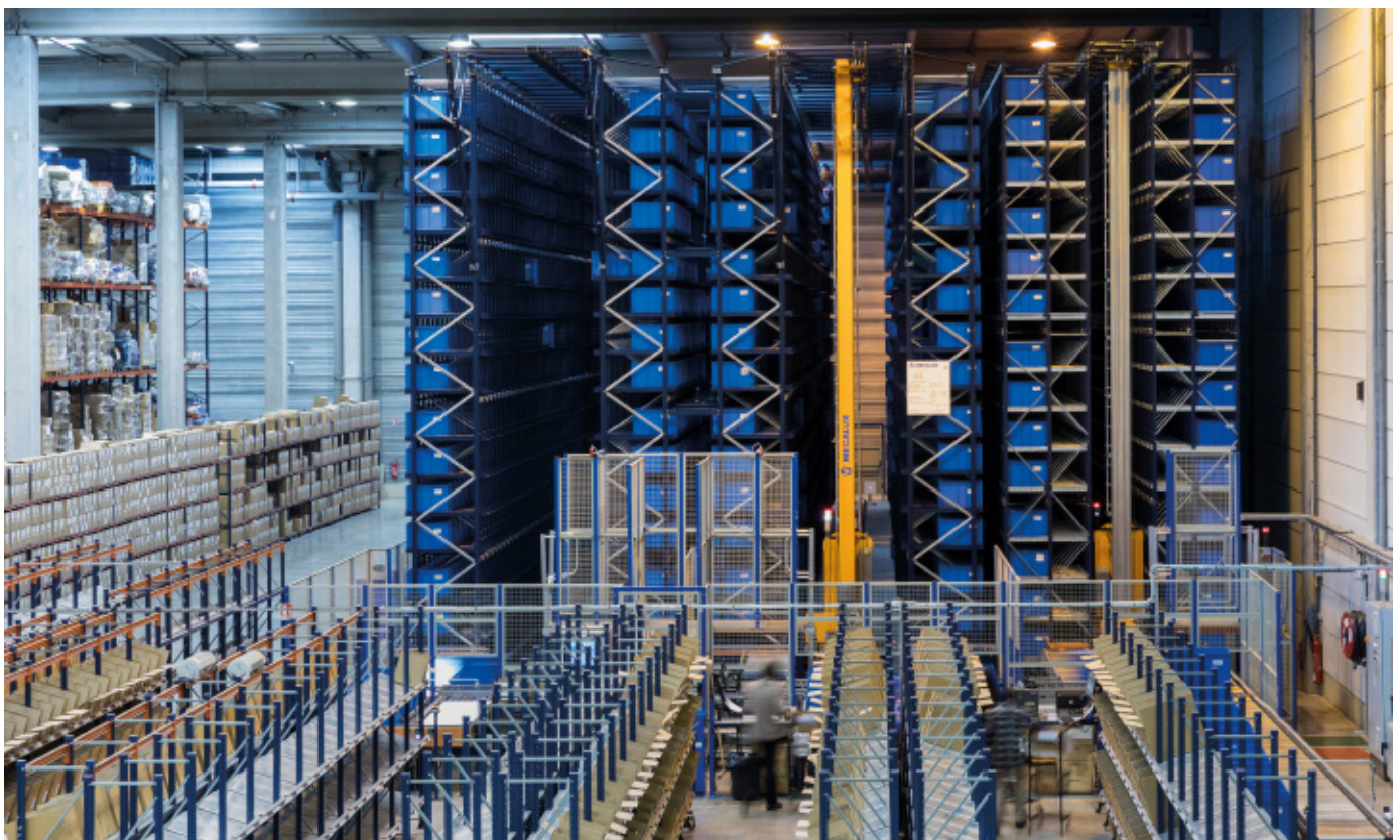
Rozwiązanie podobne do zastosowanego w magazynie Groupe Rand
