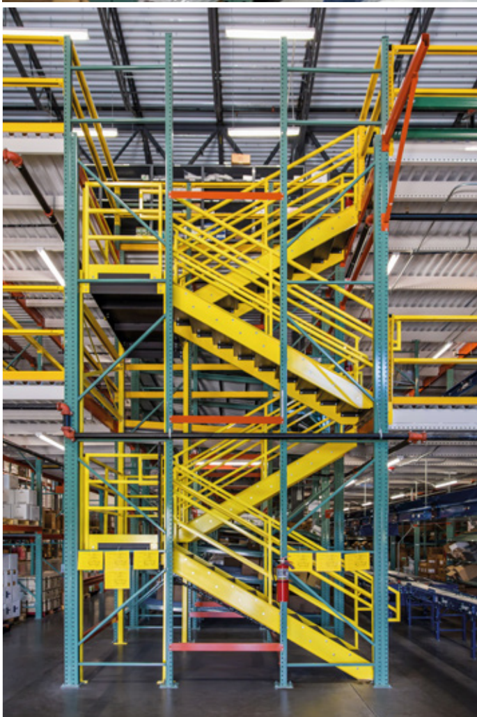
W strategicznych punktach obu bloków regałów znajdują się schody zapewniające dostęp do poszczególnych kondygnacji.
