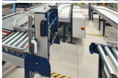
Zastosowanie przenośnika uchylnego ułatwia operatorom przemieszczanie się po obiekcie.
